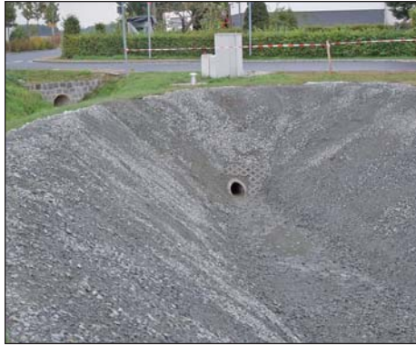
Die Aushubmassen des Ponickauer Rückhaltebeckens wurden zur Dammerrichtung im Ortsteil Naundorf durch den Bauhof aufgebracht.
