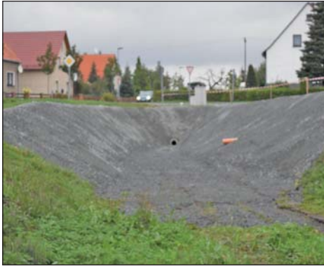
Fertiggestelltes Rückhaltebecken in Ponickau
