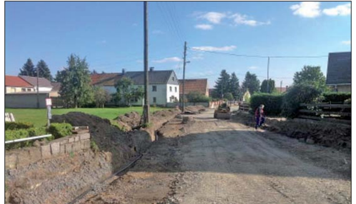
Verlegung der Elt-Kabel
