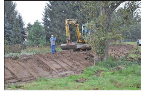
Die Aushubmassen des Ponickauer Rückhaltebeckens wurden zur Dammerrichtung im Ortsteil Naundorf durch den Bauhof aufgebracht.
